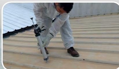
Reparo sobre parafusos e rebites afetados por corrosão
