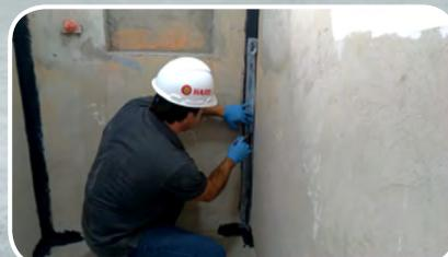
Reforço em pontos críticos de impermeabilização (cantos e arestas) com Flexfelt Standard
