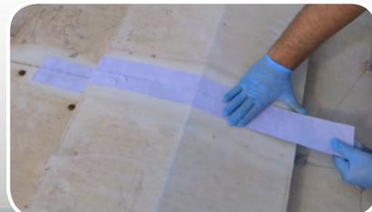
Sobreposição de chapas com Flexfelt Autoadesiva
