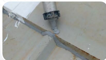
Reparo de áreas onde houve o aperto excessivo do fixador (ruptura da borracha de EPDM)
