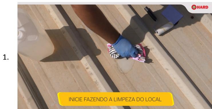
Efetue a limpeza do local, para isso recomenda-se o uso do Hard Cleaner 998. A superfície deve estar completamente seca, livre de pó, graxa, tinta, óleo e desmoldante.
