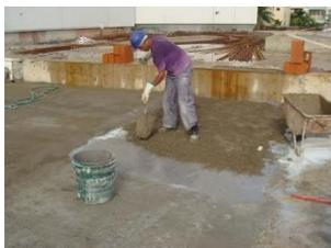
**PASSO 3:** Lançar na superfície 0,5 litros/m<sup>2</sup> da mistura dos componentes líquidos; em seguida lançar 0,5 litros/m<sup>2</sup> da mistura dos componentes sólidos e vassourar para fazer a mistura dos produtos.
