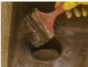
Nos ralos cobrir 40cm x 40 cm e 5cm na parte interna do tubo de PVC. (Sem tela estruturante)
