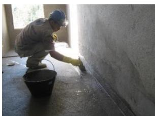
**PASSO 2:** Fazer a aplicação com pincel, trincha, rolo ou desempenadeira de aço lado liso começando pelos cantos;
