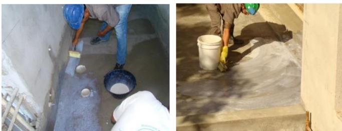
Não deixar empoçar a solução no substrato, a aplicação pode ser feita com trincha, rolo ou pincel.
