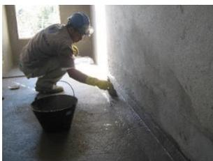
**PASSO 1:** Fazer a aplicação com pincel ou trincha começando pelos ralos e rodapés (Sem tela estruturante);
