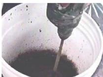
**PASSO 2:** Colocar em um recipiente limpo a proporção de produtos a serem preparados, misturar mecanicamente de 3 a 5 minutos até obter uma mistura homogênea e sem grumos.
